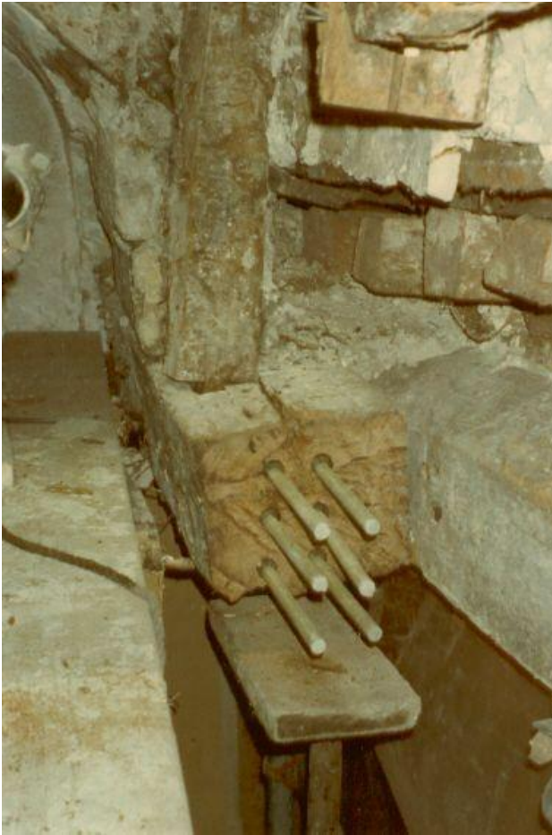
Réparation par assemblages bois par goujons collés
