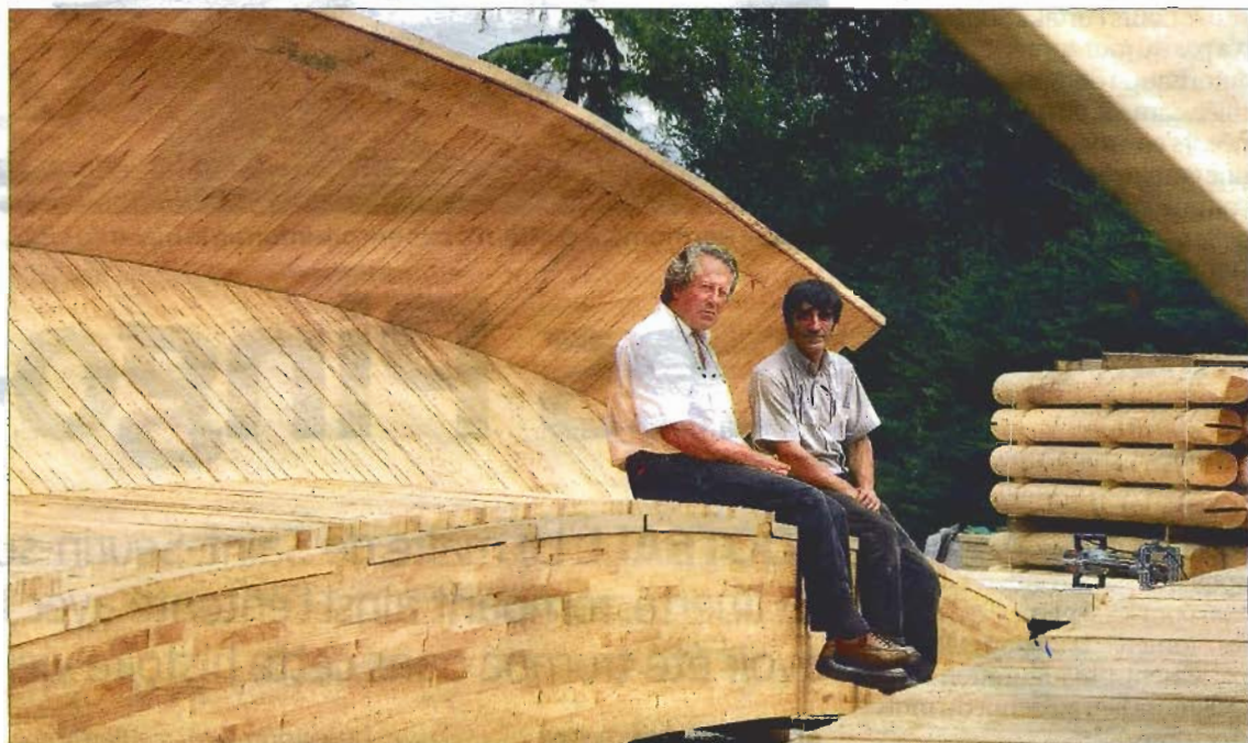
Un des tronçons de la passerelle de Tadashi Kawamata, réalisé chez Lamécol, avec Jean-Marc Lefèvre, le directeur, et Bernard Fèvres, le chef d'atelier. PHOTO FABIEN COTTEREAU
