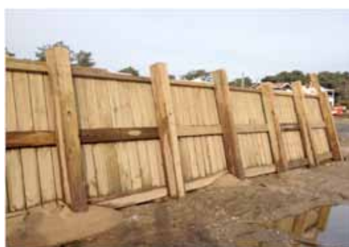
Chantier Sud Fondations – Piraillan (33)
