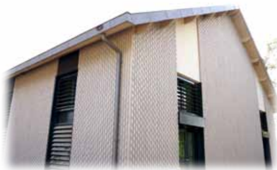
Salle Municipale Polyvalente de Parempuyre Bardage Ondulé - Procédé ABOVE
