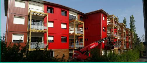
Amélioration des performances énergétique thermique et acoustique, réduction efficace du nombre de ponts thermiques, travaux d'isolation en site occupé, pas de perte de surface au sol, simplicité de mise en œuvre et nuisance faible du chantier en filière sèche pour les habitants. A cela s'ajoute le côté esthétique du rajeunissement extérieur des façades qui redonne une seconde vie au bâtiment. Une belle opération qui permet la mise en avant des entreprises et des bois de nos régions !
