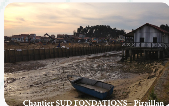
Chantier SUD FONDATIONS - Piraillan
