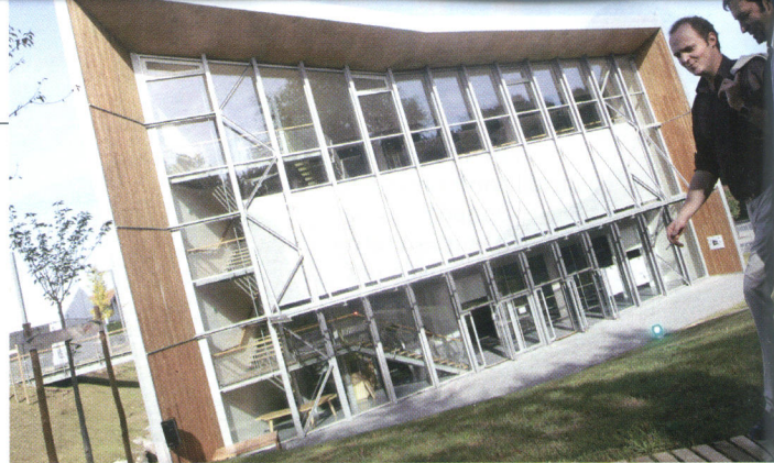
Nobatek dispose d'un bâtiment écologique tout à son image
