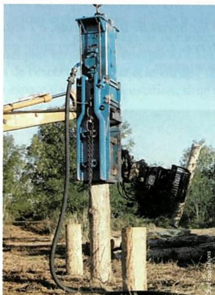
autorisent une charge admissible maximale par appui de 40 tonnes. Ils sont mis en place par battage dans des sols compressibles saturés en eau. Les essences choisies – pin, chêne ou robinier – sont PEFC ou FSC. Dans le cas d'une immersion permanente, des bois plus durables pourront être utilisés. Plus d'information sur [www.sudfondations.fr](http://www.sudfondations.fr)
