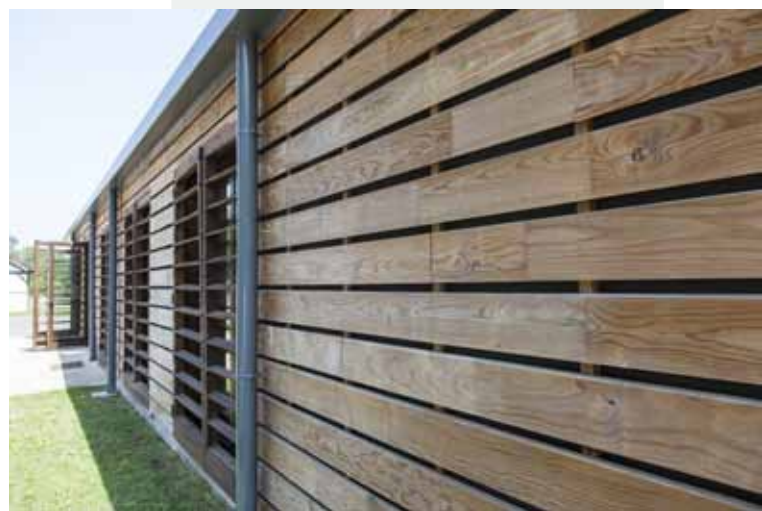
Façade ouest de l'école primaire de Garein (40)
