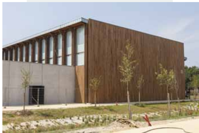
Gymnase du collège de Labrit (40)
