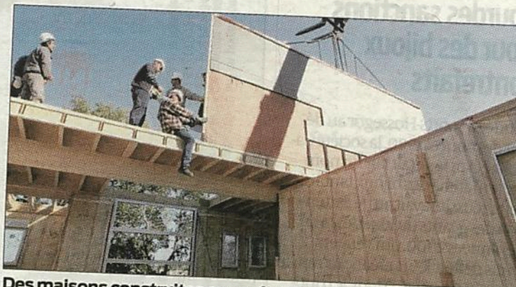
Des maisons construites ou surélevées avec du bois. ARCHIVES S. L.
