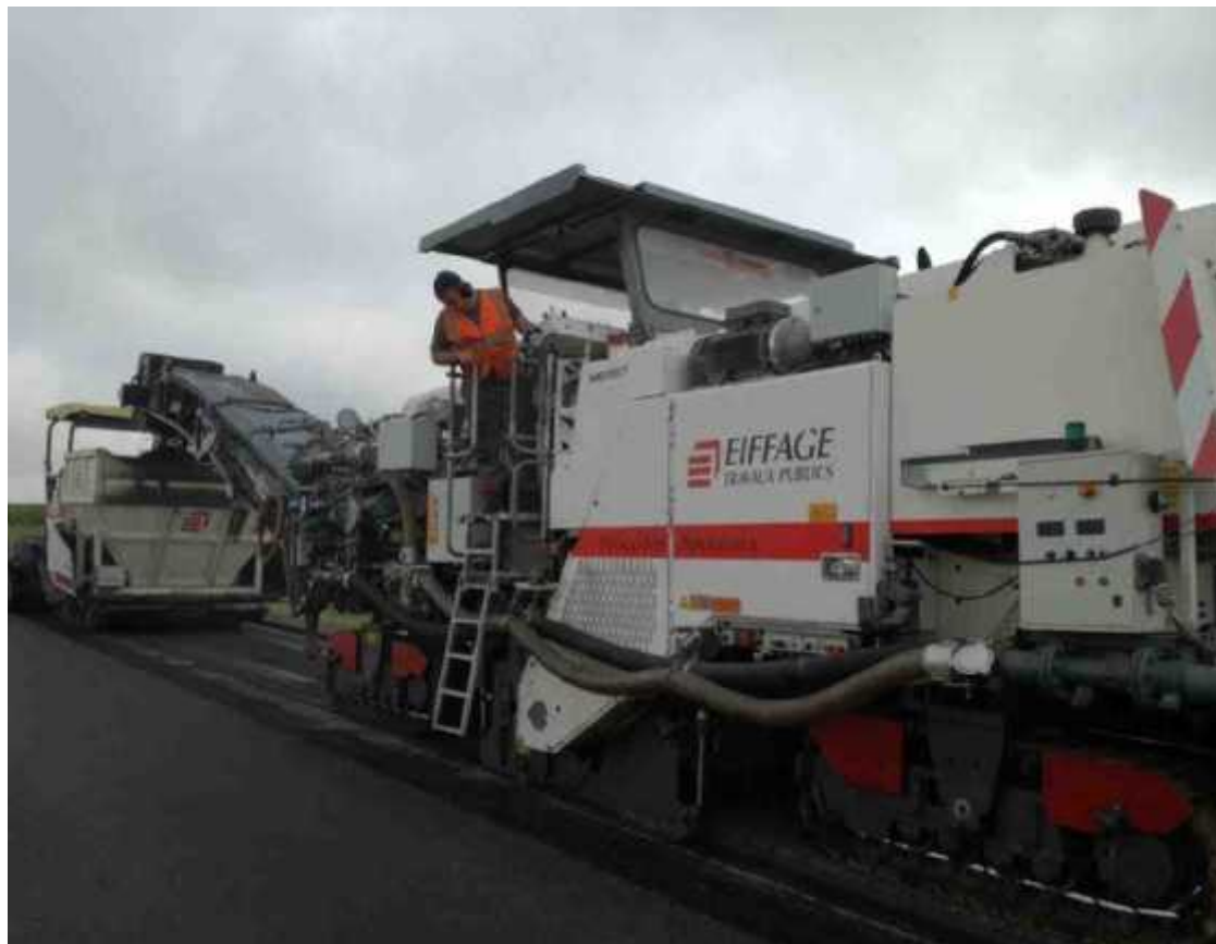
Sur la D 670, les techniciens d'Eiffage posent le nouvel enrobé « révolutionnaire ». PHOTO S.J.
