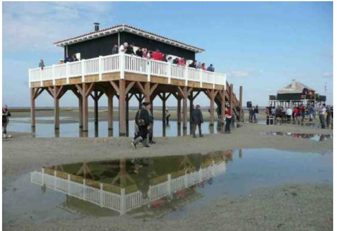
La cabane 53 (au premier plan) a été reconstruite au cours de l'hiver 2007/2008. ARCHIVES B.D.
