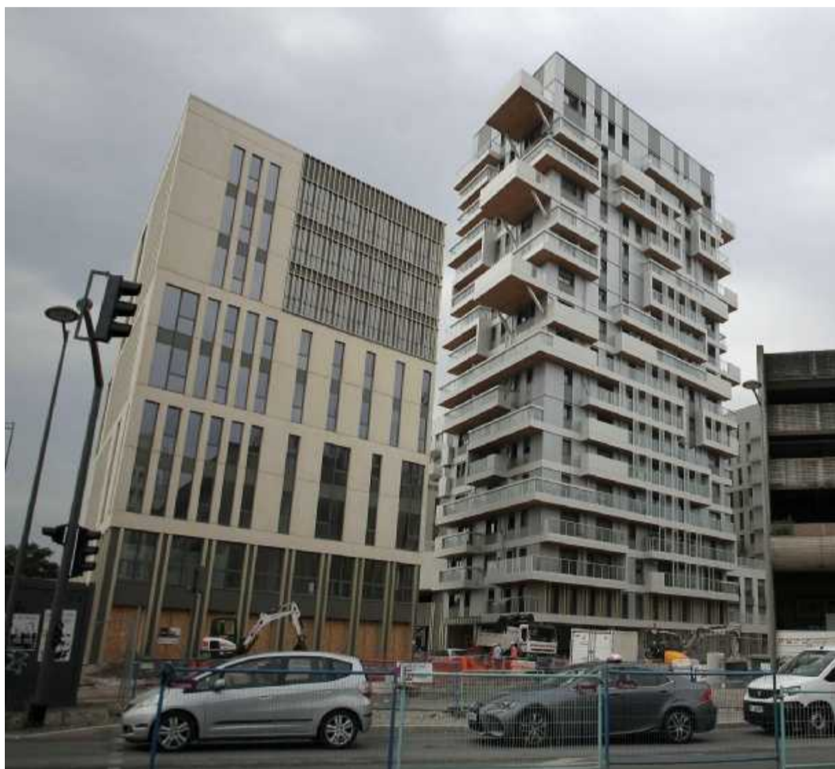
Hypérion, première tour bois/béton de 55 m, vient d'être livrée dans le quartier Euratlantique. L. THEILLET
