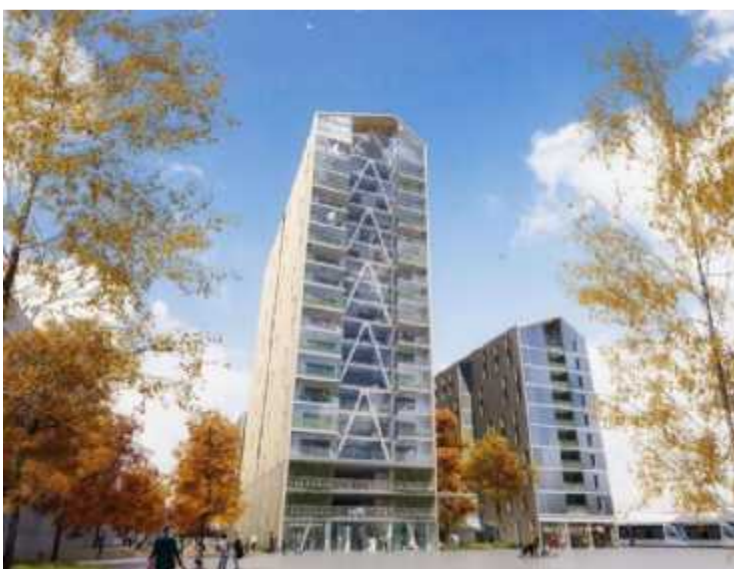
Une image de synthèse de la tour Silva, dont le chantier est en cours. QUICK IT
