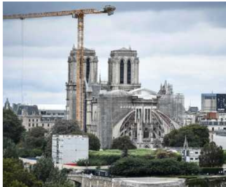
La mise en sécurité de l'édifice s'est achevée cet été.
