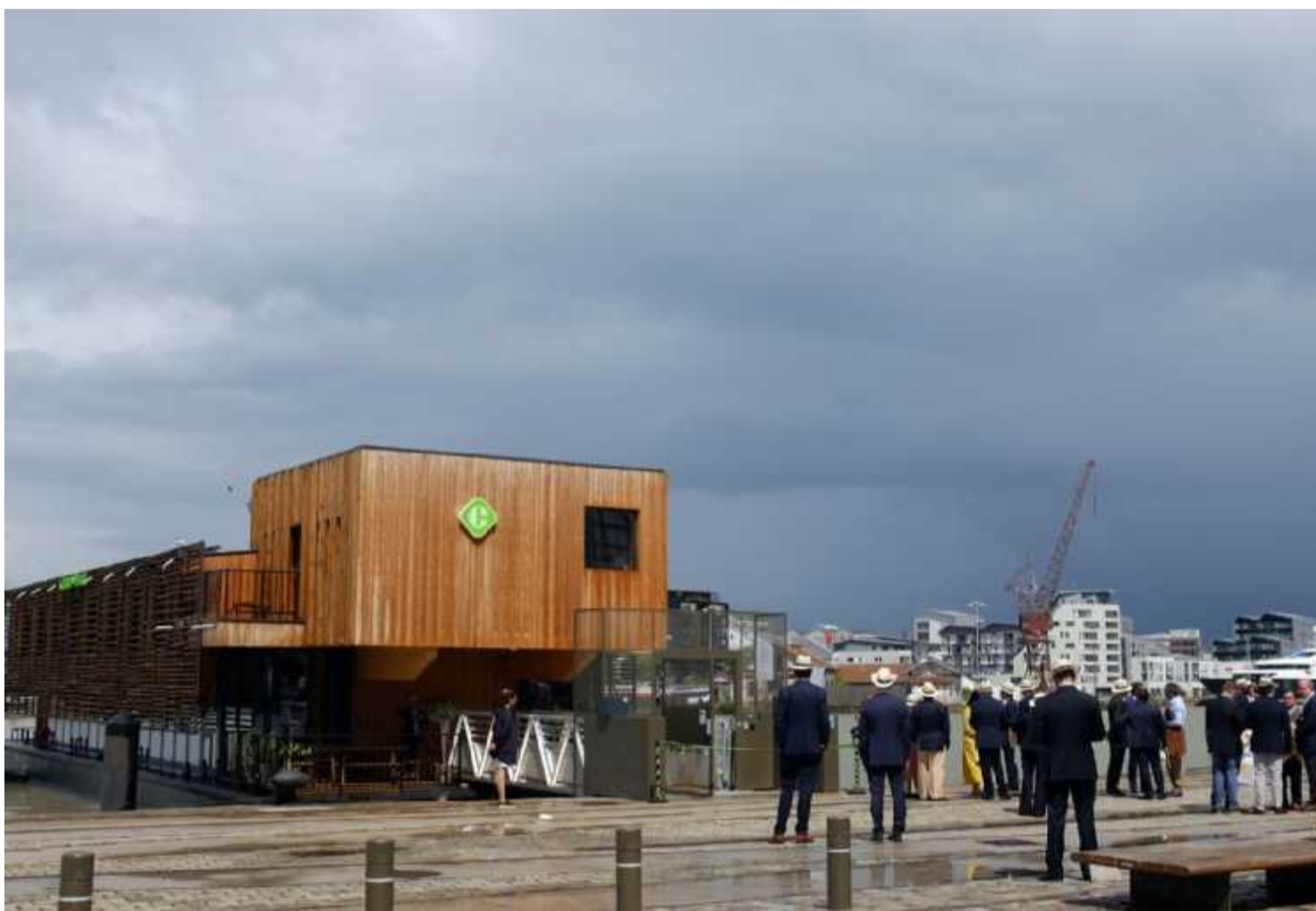
Le support du bâtiment est une barge de 31 mètres de long sur 11 mètres de large. PHOTOS LAURENT THEILLET / « SUD OUEST »
