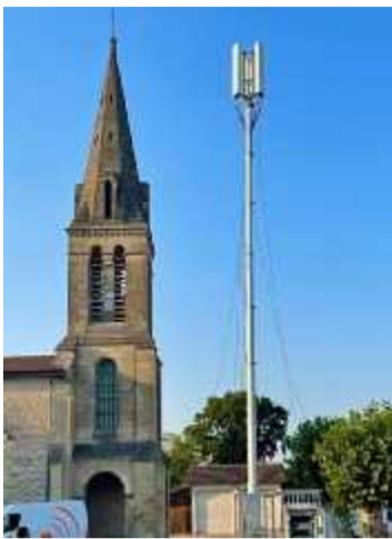
L'antenne-relais installée sur la place de Louchats. ORANGE
