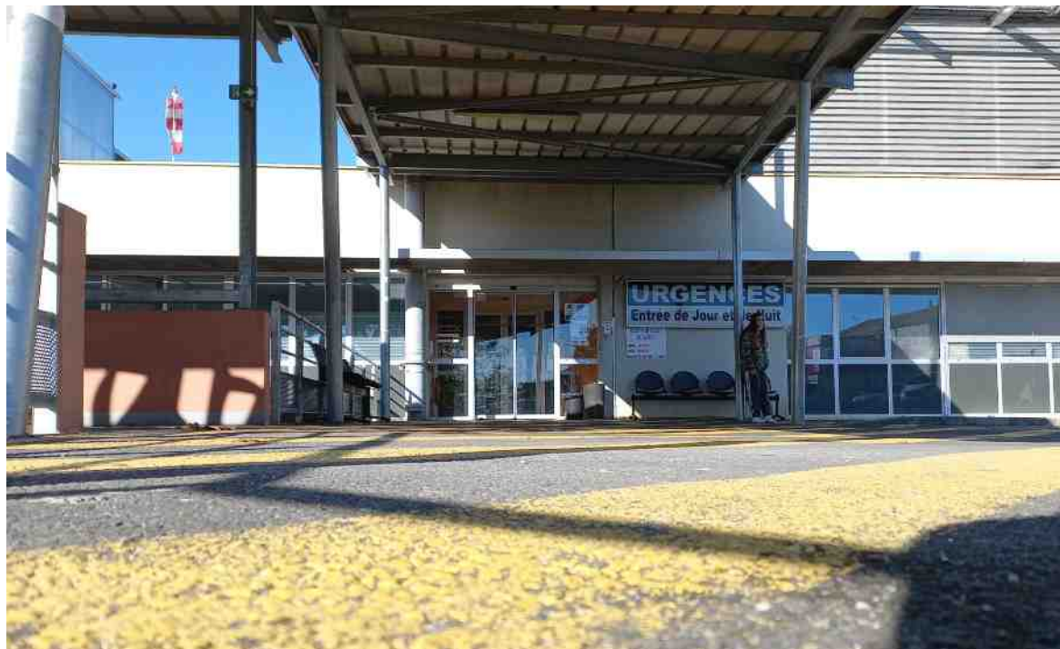
L'hôpital de Langon aimerait réduire sa facture énergétique grâce à ce système de réseau de chaleur mutualisé. ARCHIVES A.D.
