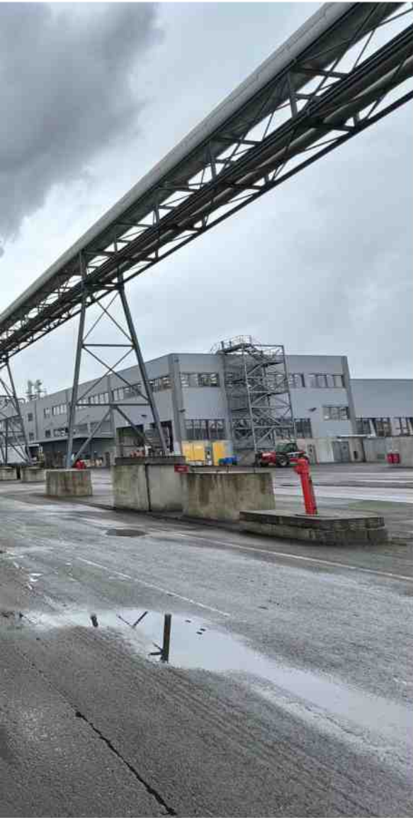
La centrale biomasse couvre l'essentiel des besoins énergétiques de l'usine Egger. P.R.P.R. / SO
